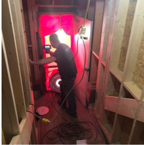
Left: Blower Door Testing
