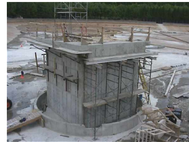
New 90” Valve Structure
